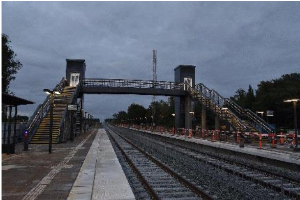
Den nye gangbro i Nv .
